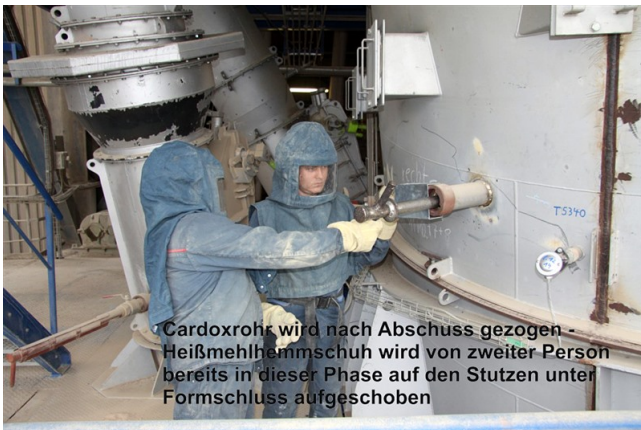
Phase 1: Ziehen, Cardoxrohr und bereits augesteckter Hemmschuh
