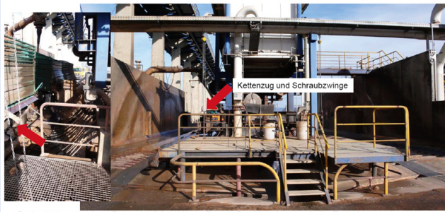
Podesthöhe ca 1,2 m. Fahrzeug fährt mit geöffneten Bordwänden durch die Entladung und rangiert nach Waschprobenentnahme wieder zurück
