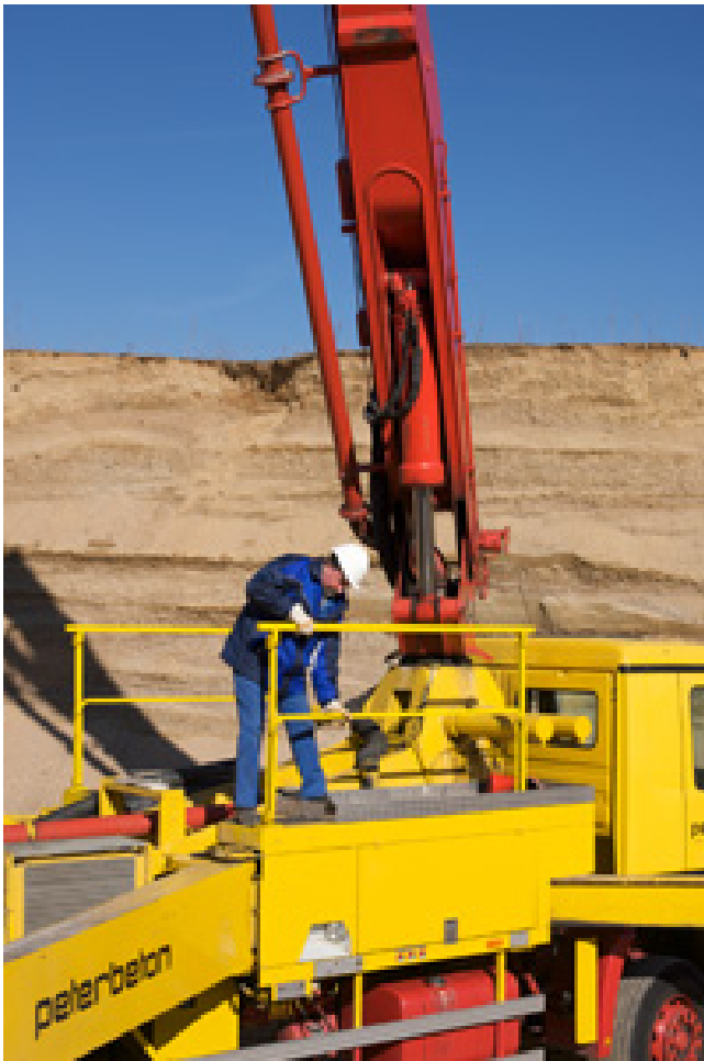
Montage der Absturzsicherung
