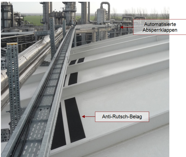
Abb. 2: Tankoberseite mit bereits installiertem Kabelkanal
