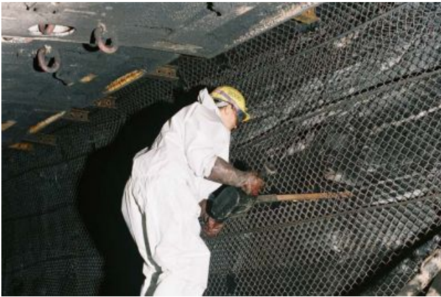
Arbeiten im Streb
